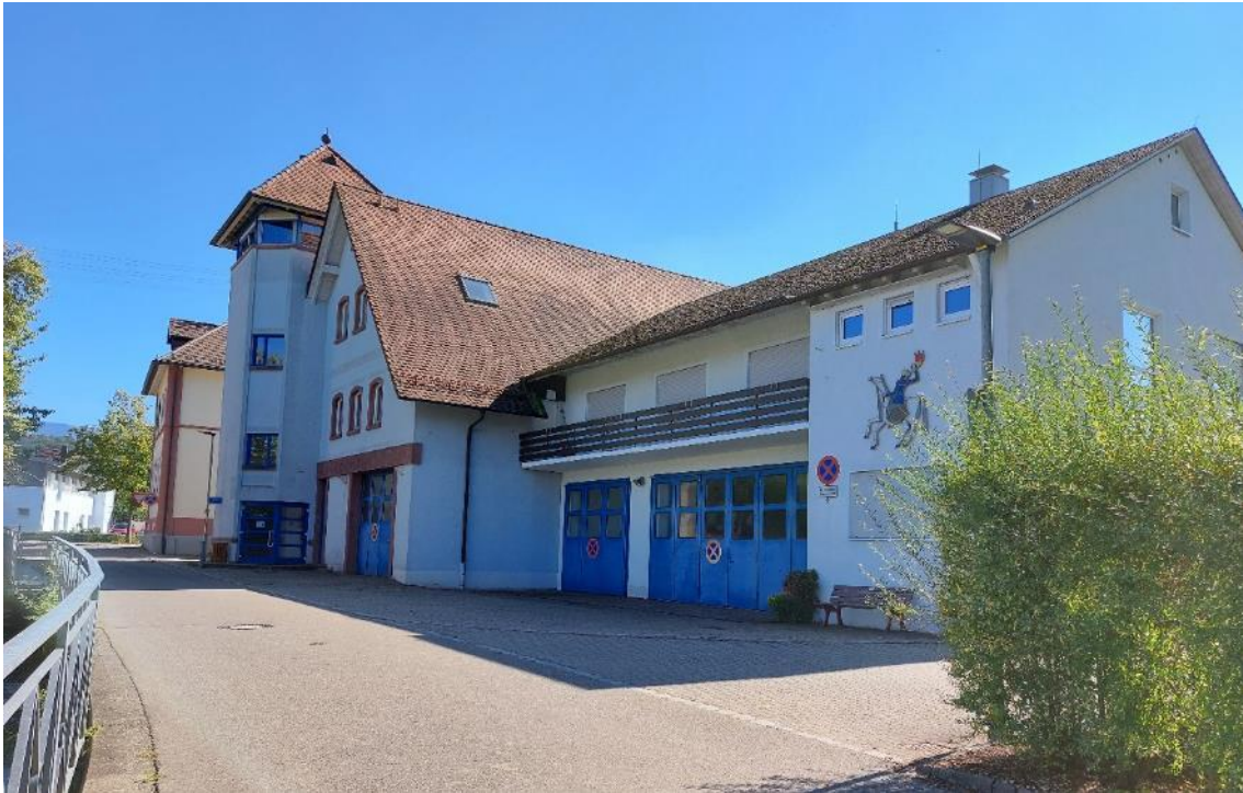
Dorfgemeinschaftshaus (links) Feuerwehrgerätehaus (rechts) im Wassergässle, Quelle: Eigene Fotografie
