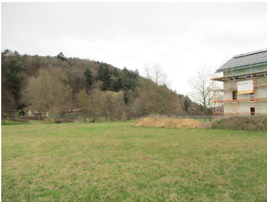
Abbildung 1 Baufäche, Blickrichtung Nordwesten, rechts: Soziales Wohnen
